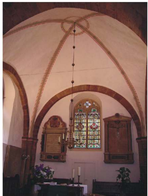
Das Gewölbe der Apsis
