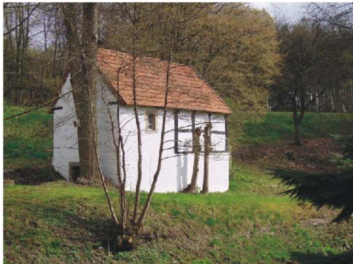
Backhaus Mühle Bohle
